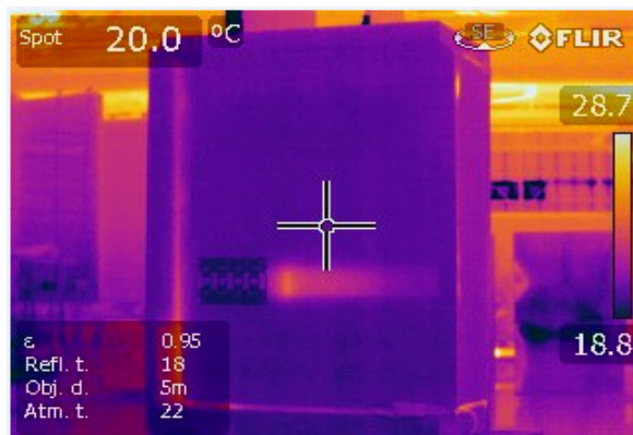
9 pav. Naujos konstrukcijos izoterminės pertvaros su terminiu atskyrimu termograma – sienelės sujungime su grindimis šalčio tilto nebėra (pertvaros sujungimai su priekio siena ir stogu, krovinio tvirtinimo juosta nevertinama)
