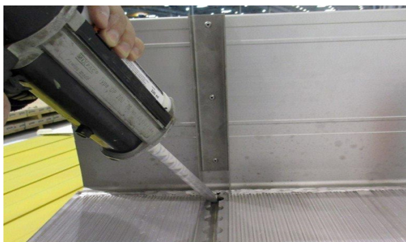
6 pav. Kėbulo izoterminės grindyse dėl terminio atskyrimo padarytas pjūvis sandarinamas Koemerling Koerapur 489 dviejų komponentų silikoniniais klijais
