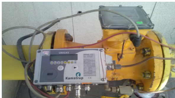
1 pav. Gamtinių dujų apskaitos įrenginys „Schlumberger NM G 400“ ir elektroninis konverteris „Kamstrup UNIGAS PTS“
